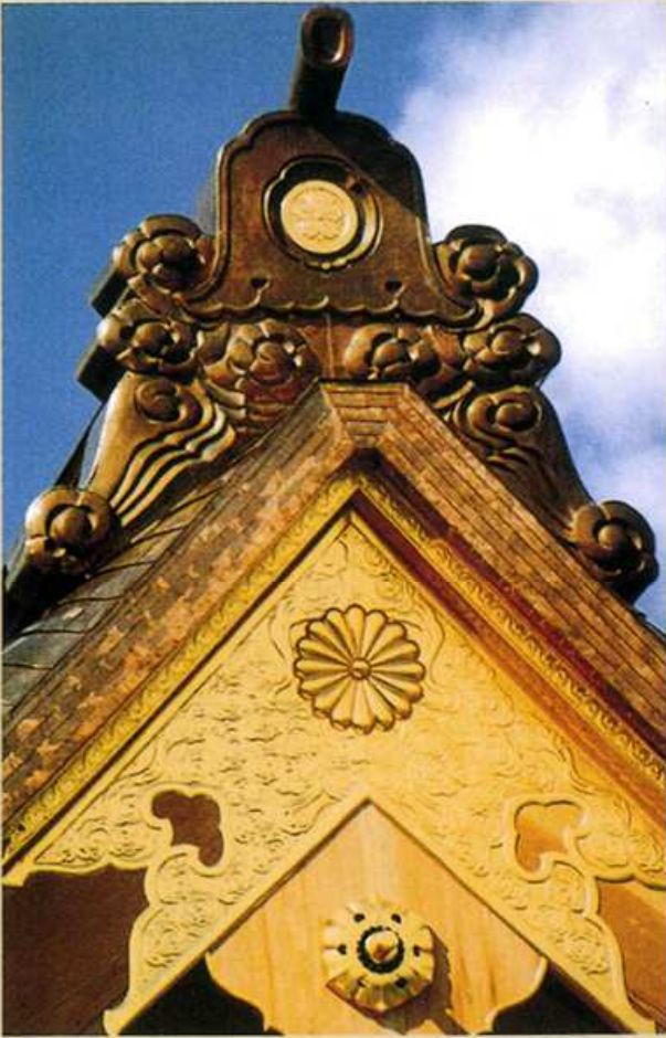
主棟打ち出し鬼と破風飾
