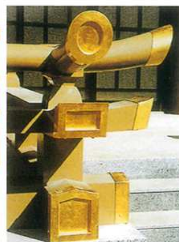
高欄隅の架木・平行・地覆飾
